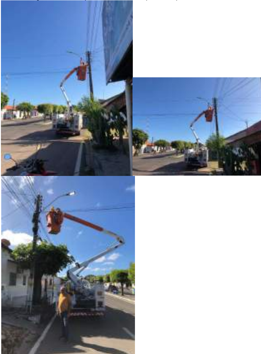
Substituição das lâmpadas comuns por lâmpadas de LED na avenida principal.
