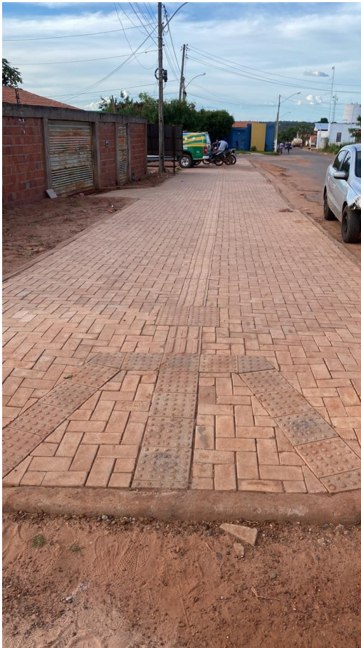
Construção de Calçamento
