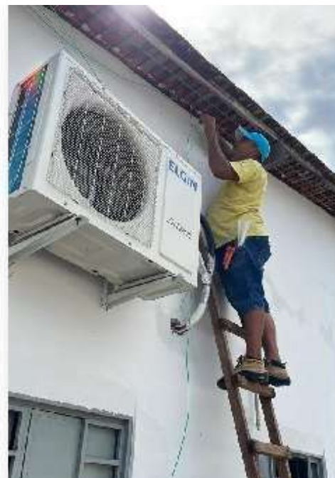
Figura 27 - Instalação de ar condicionado
