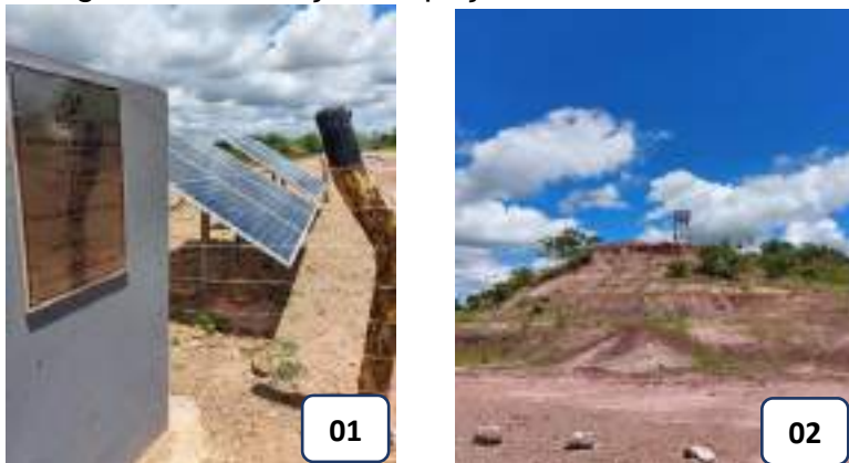
Imagem 01 Instalação de poço na comunidade Planalto da Alvorada
