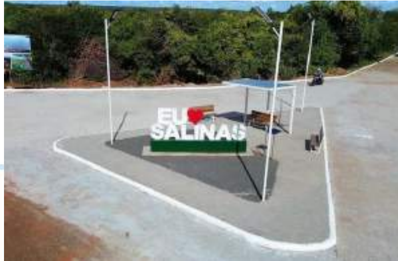
Figura 17 - Instalação de Letreiro e Recuperação de Calçamento no Povoado Salinas
