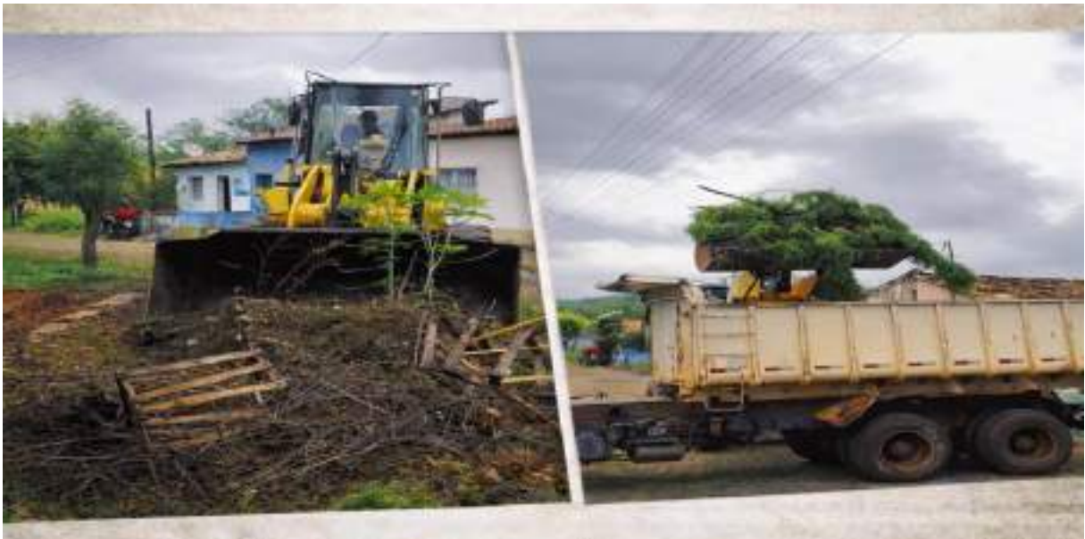
Figura 9 - Roço e Limpeza
