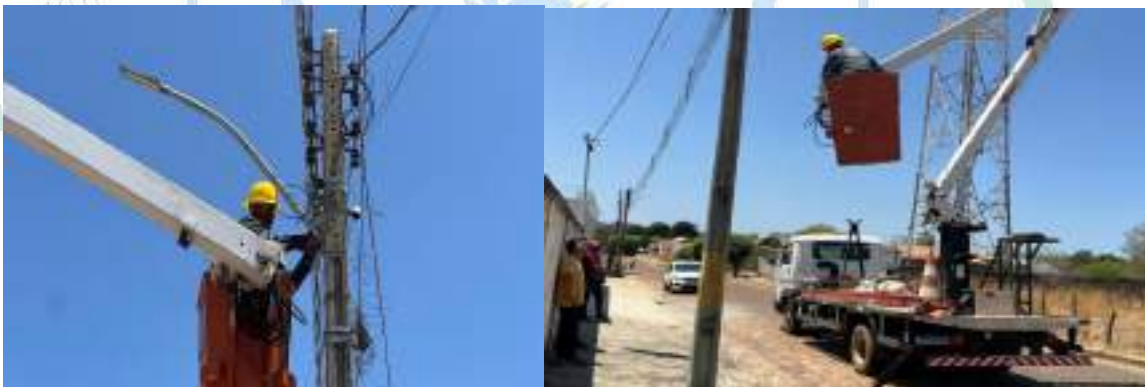
Figura 13 - Manutenção de Iluminação Pública
