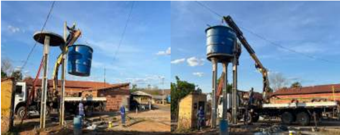
Figura 12 - Aquisição de Instalação de Novas Caixas de Água
