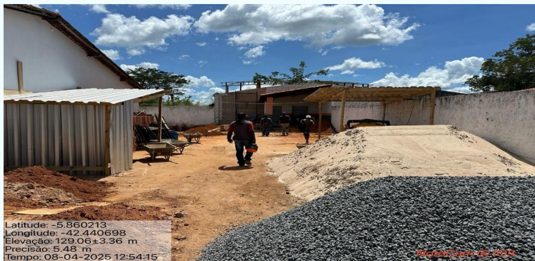
FIGURA 36 - AMPLIAÇÃO DA ESCOLA ABDIAS
