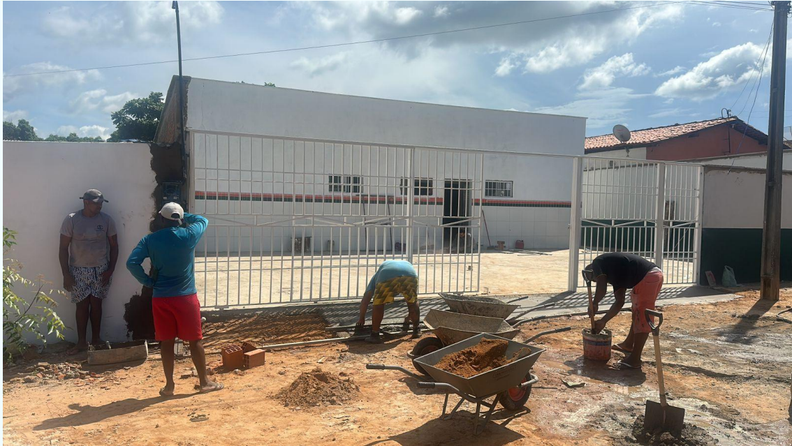
FIGURA 34 - REFORMA DA SEDE DO CREAS
