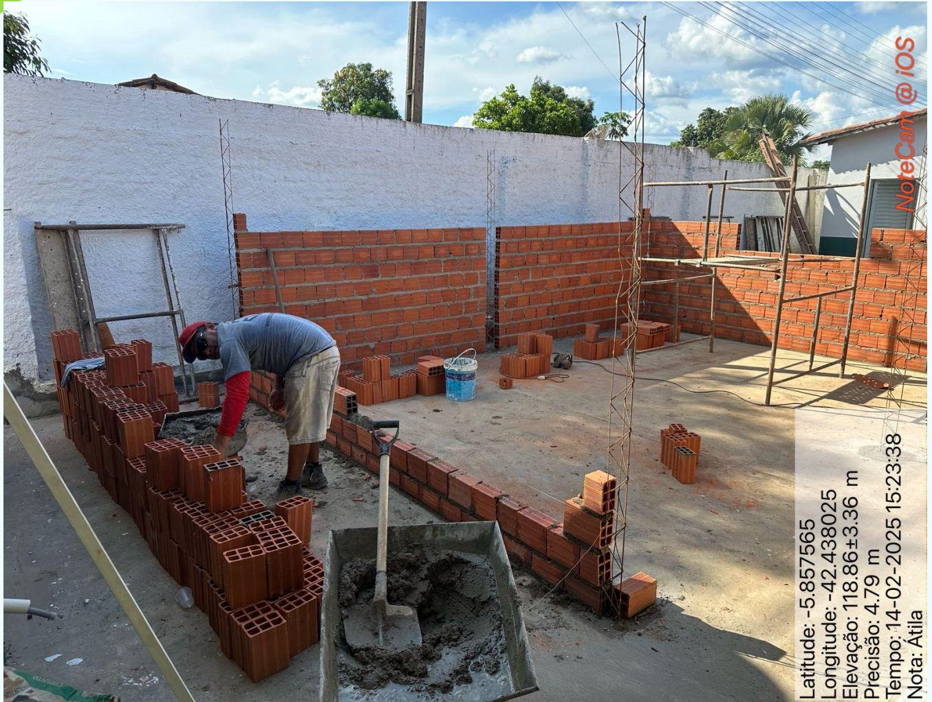
FIGURA 35 - CONSTRUÇÃO SALA DE INFORMÁTICA NA ESCOLA ATILA LIRA
