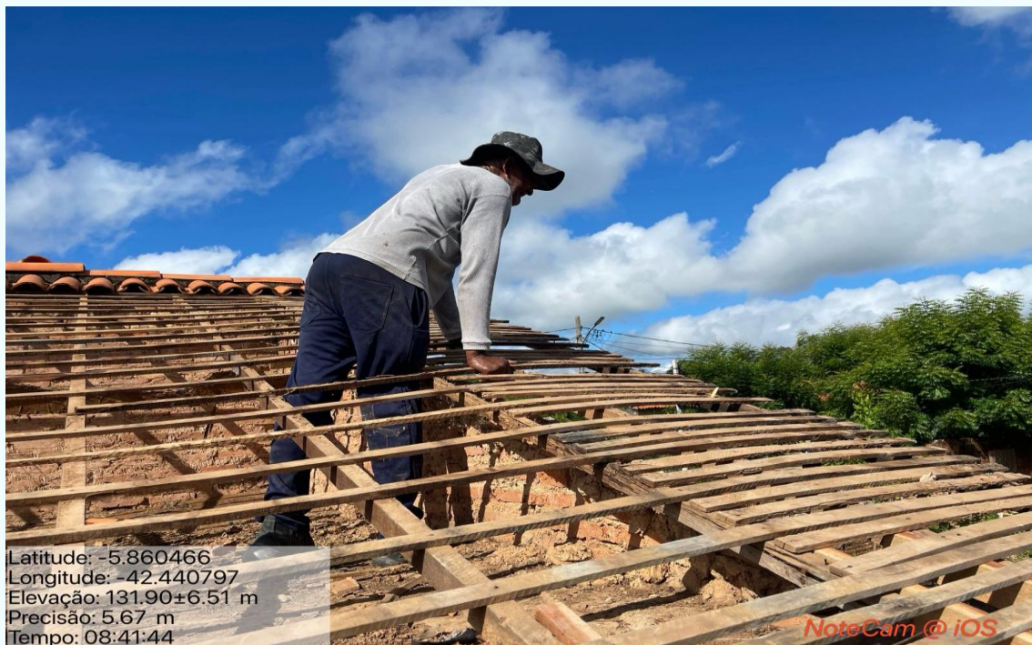
FIGURA 30 - MANUTENÇÃO DE TELHADOS
