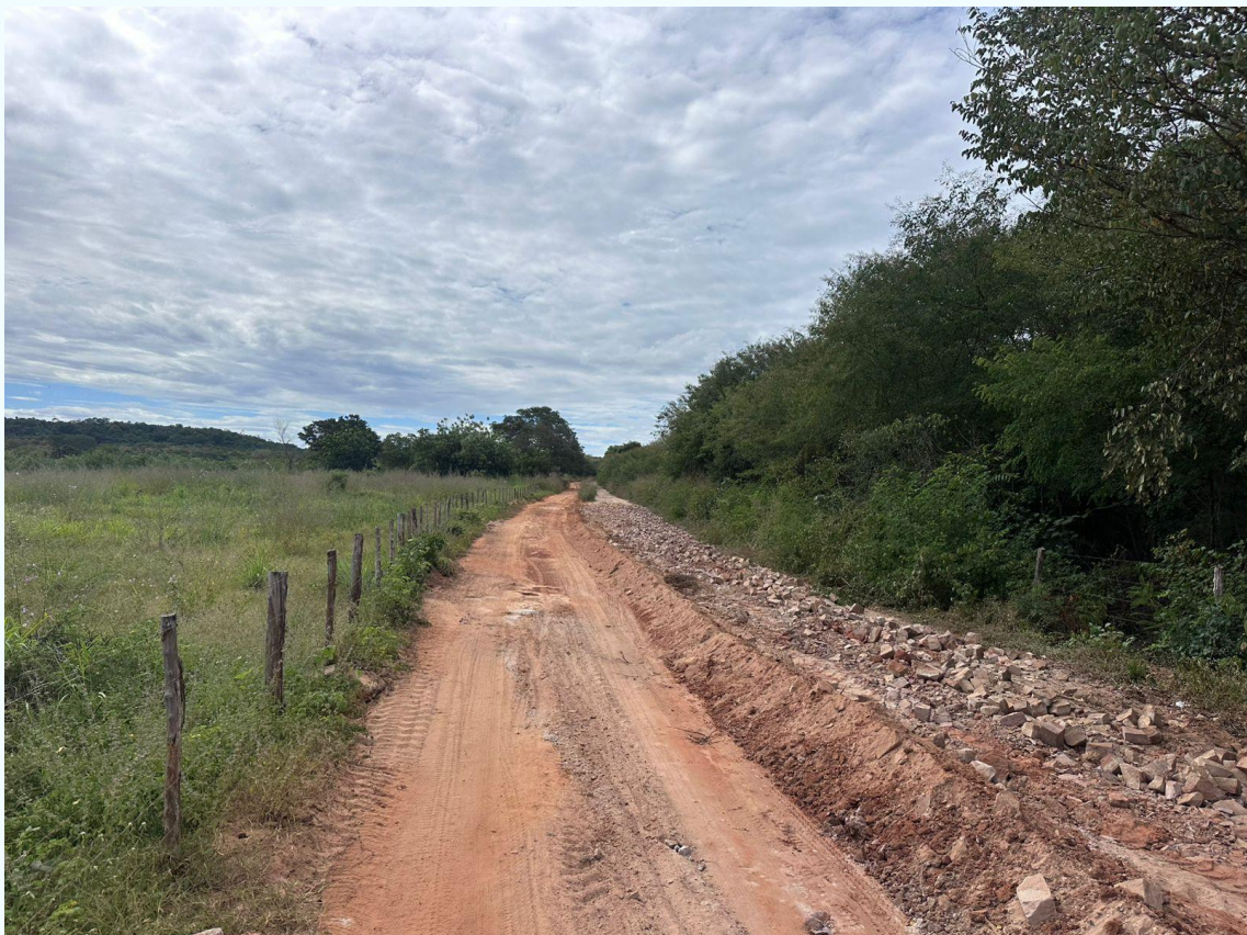
FIGURA 25 - RECUPERAÇÃO DE ESTRADAS VICINAIS
