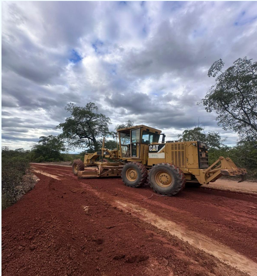
FIGURA 24 - RECUPERAÇÃO DE ESTRADAS VICINAIS
