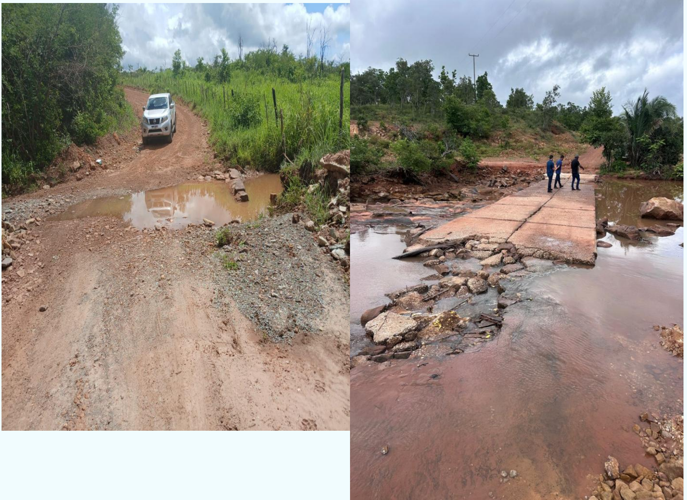
FIGURA 31 - RECUPERAÇÃO DE PASSAGEM MOLHADA
