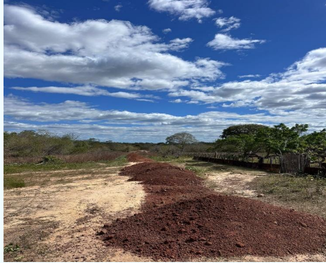
FIGURA 26 - RECUPERAÇÃO DE ESTRADAS VICINAIS
