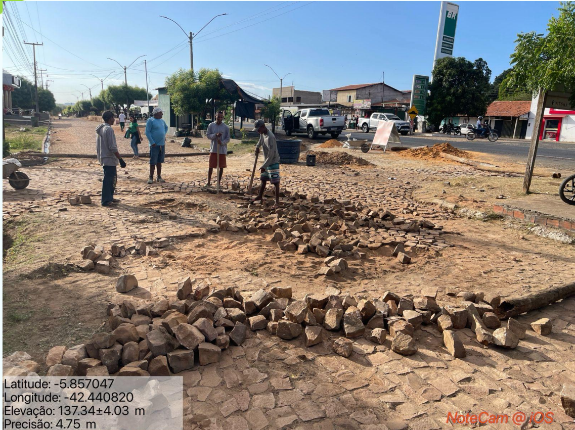
FIGURA 38 - 10 MIL M2 DE CALÇAMENTOS
