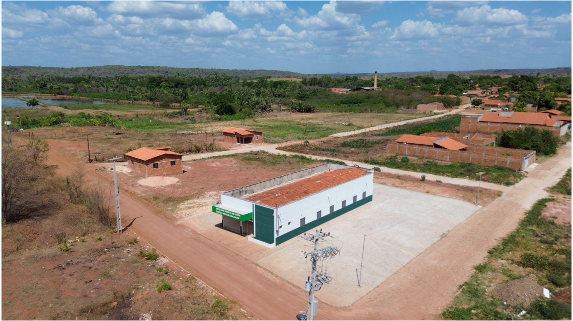
Figura 32 - REFORMA DE OBRA ABANDONADA DA SEC. DE SAÚDE.
